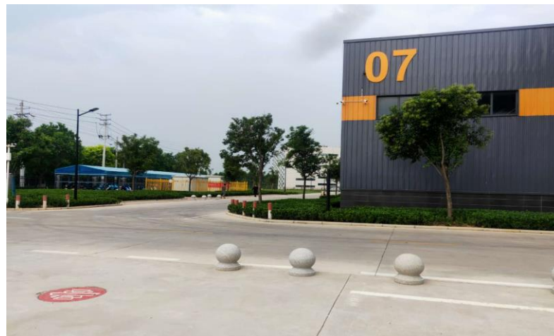
项目南侧 7#厂房
