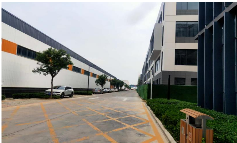
项目西侧园区道路
