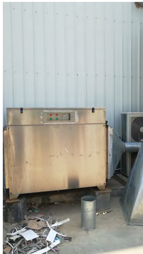
现有工程 废气处理装置 (低温等离子体)
